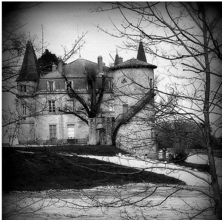
Vue du château et de l'enceinte (photo site S. Epitalon)
