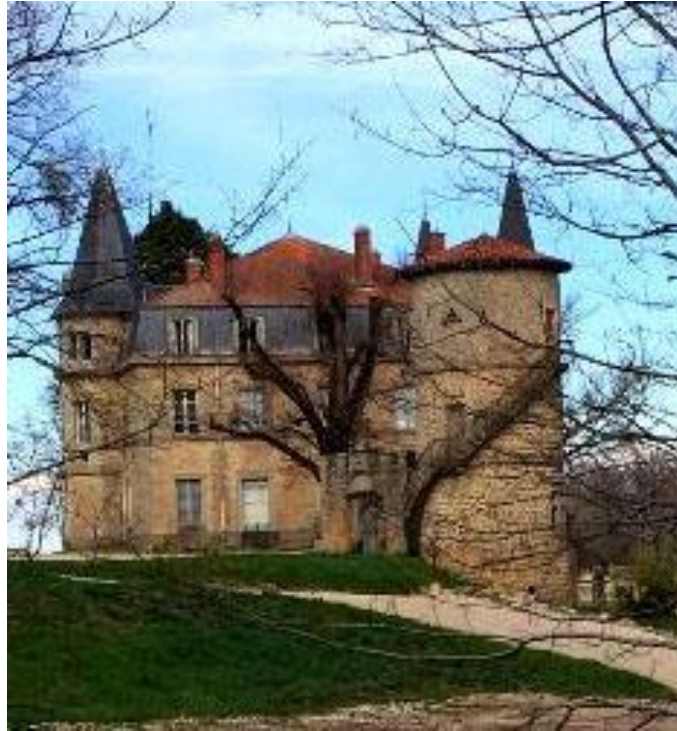
Vue latérale avec tour accolée élevée sur trois niveaux et toiture en pyramide
