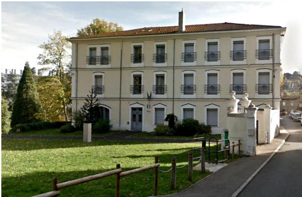
Le bâtiment après sa restauration.
