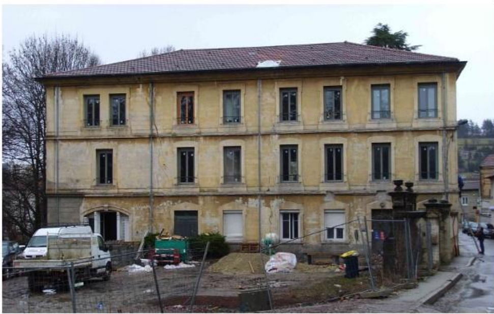
Le bâtiment en cours de restauration
