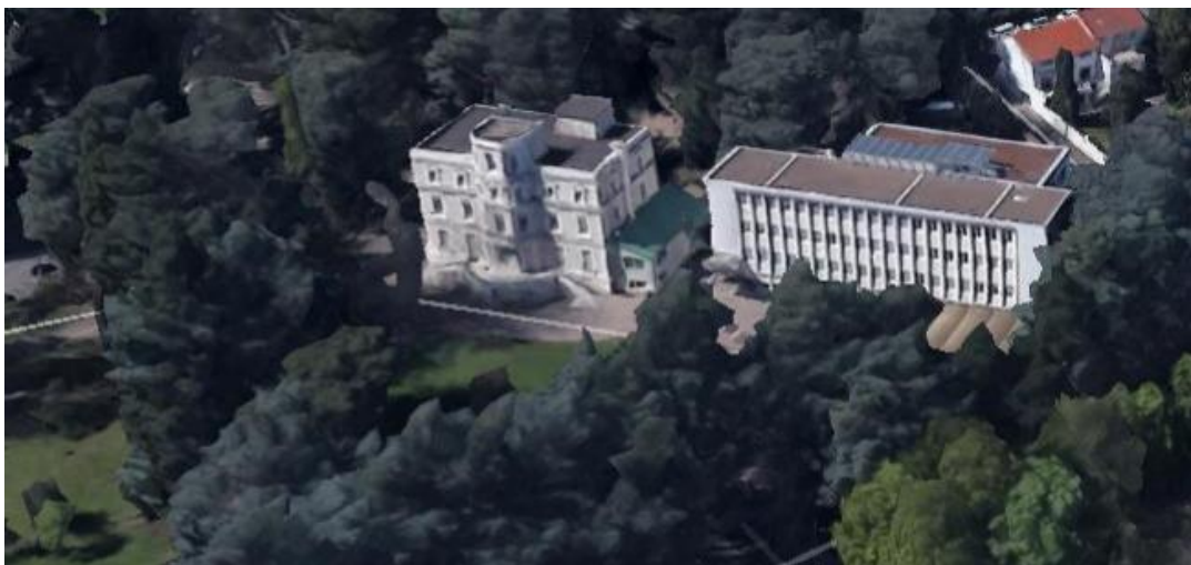
La maison de maître et les bâtiments récents
