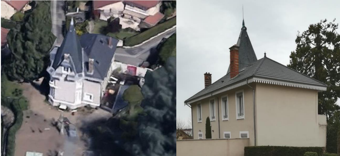
façades ouest et arrière du bâtiment
