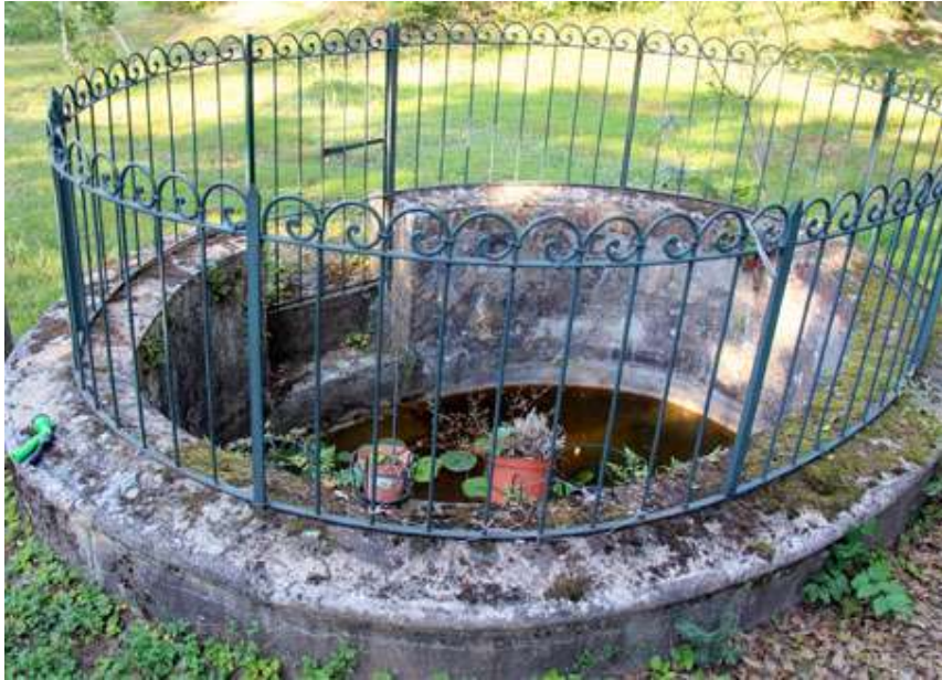
Bassin bordé d'une margelle avec grille (photo D. Tabard)
