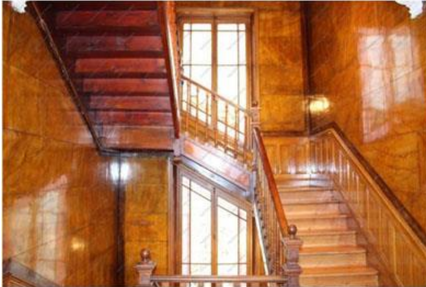
Escalier avec revêtement en placage bois
