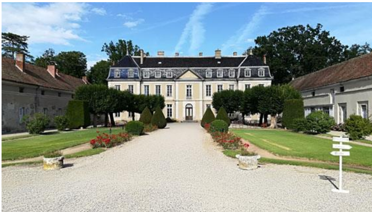
Vue de la façade ouest du château (Photo M. Bonneville)
