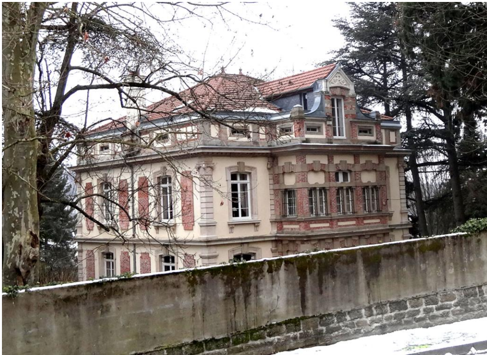
Façades ouest et nord
