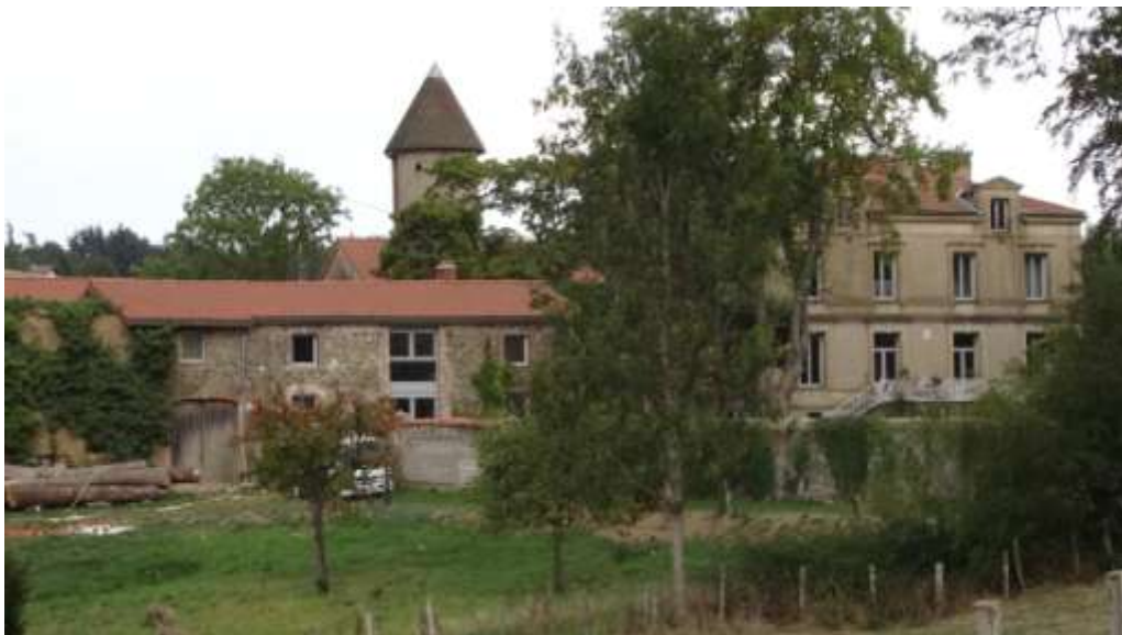
Maison de maître et bâtiment annexe en cours de rénovation. Tour pigeonier en arrière plan
