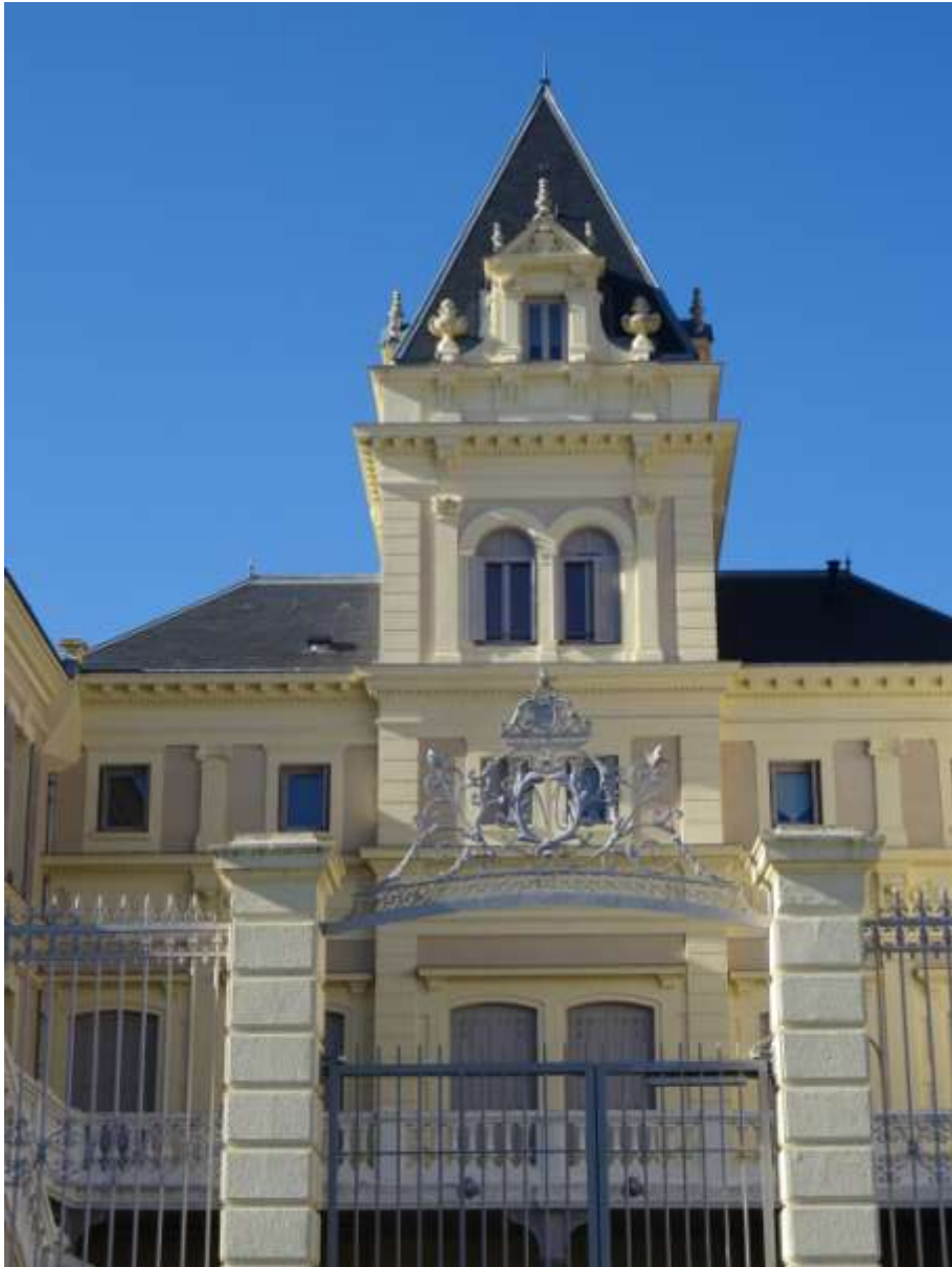
Bâtiment central et grille de la cour monogrammée Marrel
