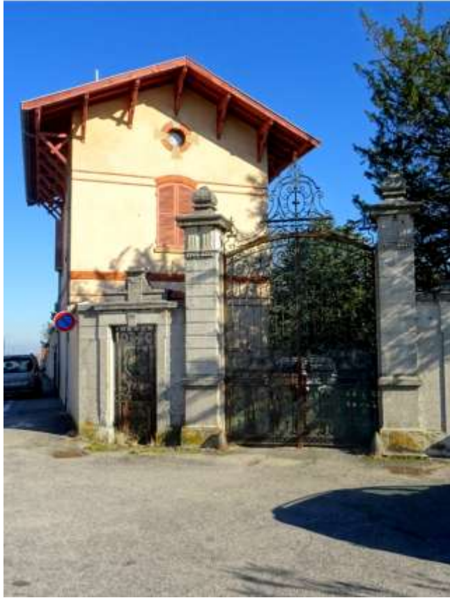
Portail et maison de gardien à l'entrée Ouest
