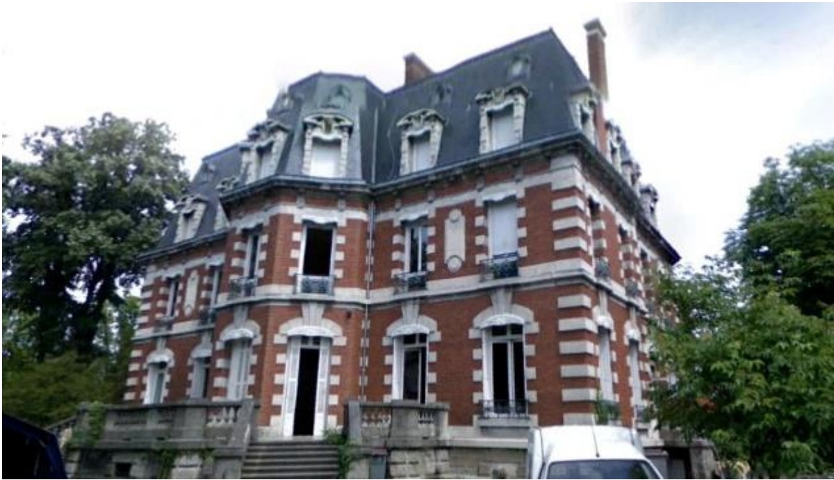
façade arrière et latérale
