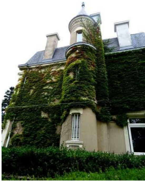
Façade latérale avec tourelle
