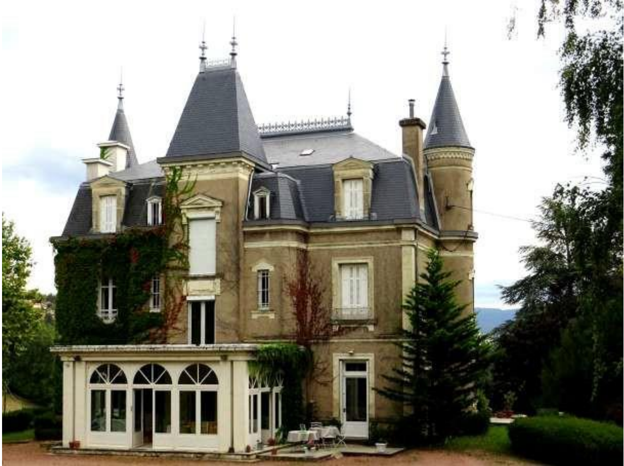
Façade arrière figurant la disposition des tourelles et de la tour centrale, ainsi que la complexité de la toiture
