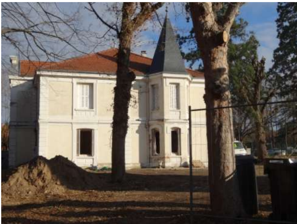
Façade latérale ouest servant d'entrée, avec tourelle accolée
