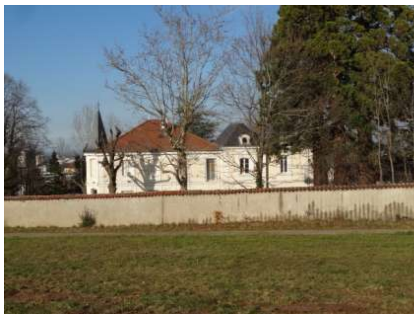
Arrière des bâtiments façade sud
