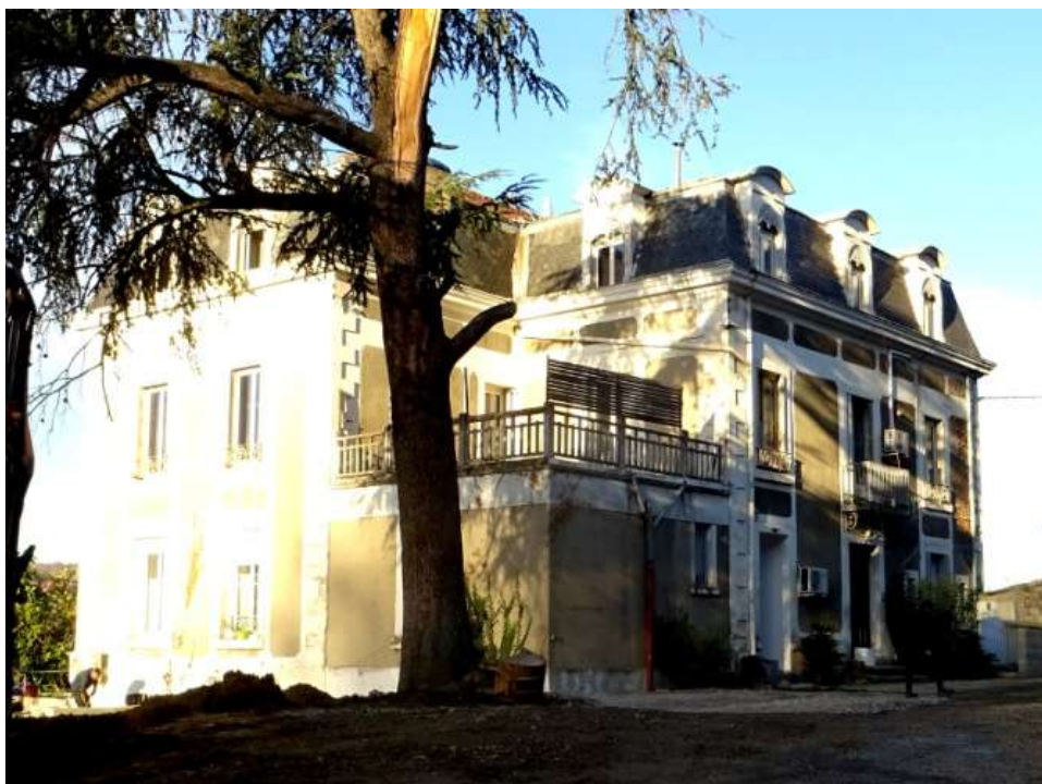
Façade arrière avec construction avec terrasse rajoutée
