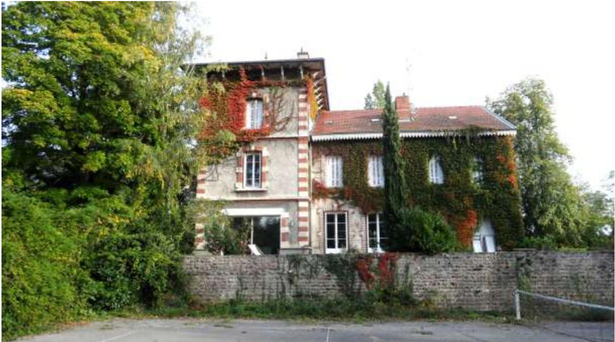
Vue de la façade ouest de la maison. Au-delà du tennis, on distingue le mur de soutien. Il permet de protéger la maison des inondations qui peuvent monter à mi hauteur. On identifie également très nettement les deux phases de construction : à droite la partie plus ancienne sur deux niveaux. A gauche, la partie plus récente avec 3 niveaux, ajoutée par Lamaizière en 1895-96.
