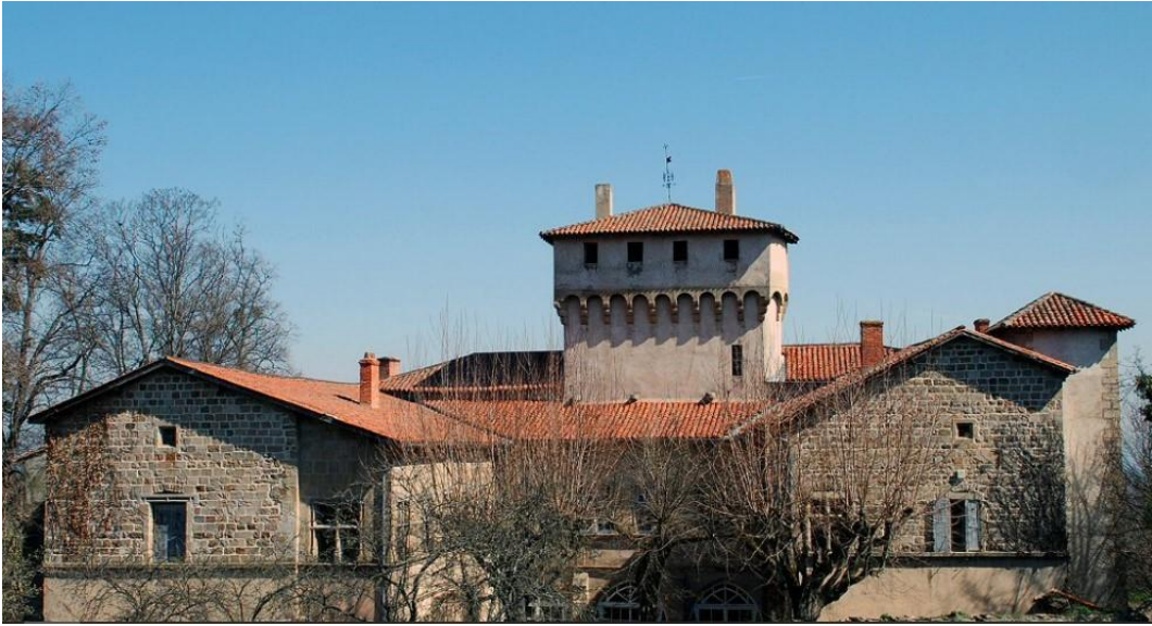
Façade ouest côté cour
