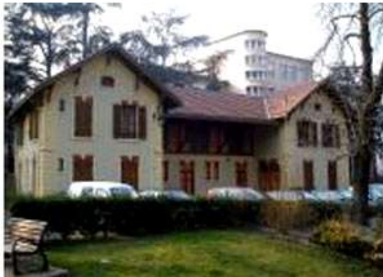
Bâtiments des communs implantés sur la rue Benoît Oriol
