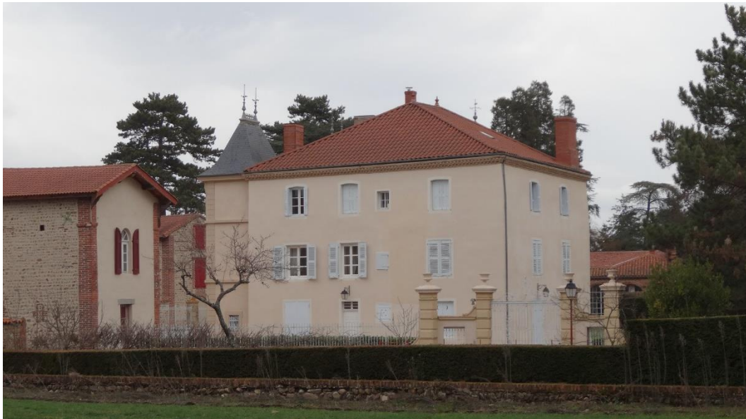
Vue arrière du château
