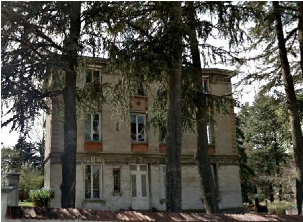
Vue arrière de la maison
