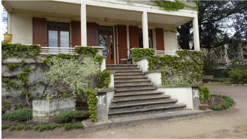
au premier niveau, les bornes au pied de l'escalier portent encore des idéogrammes vietnamiens
