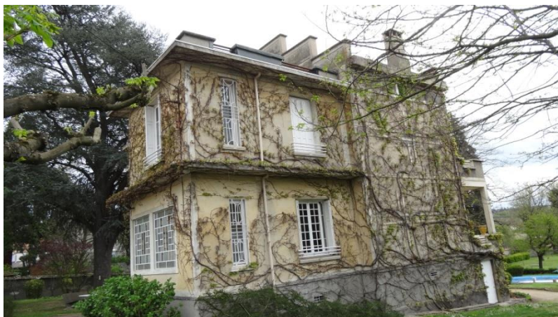
Vue de la façade ouest
