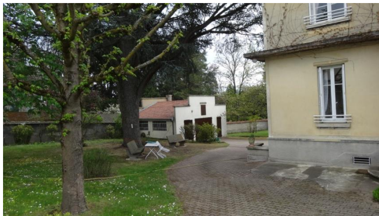
Bâtiment annexe comportant la buanderie
