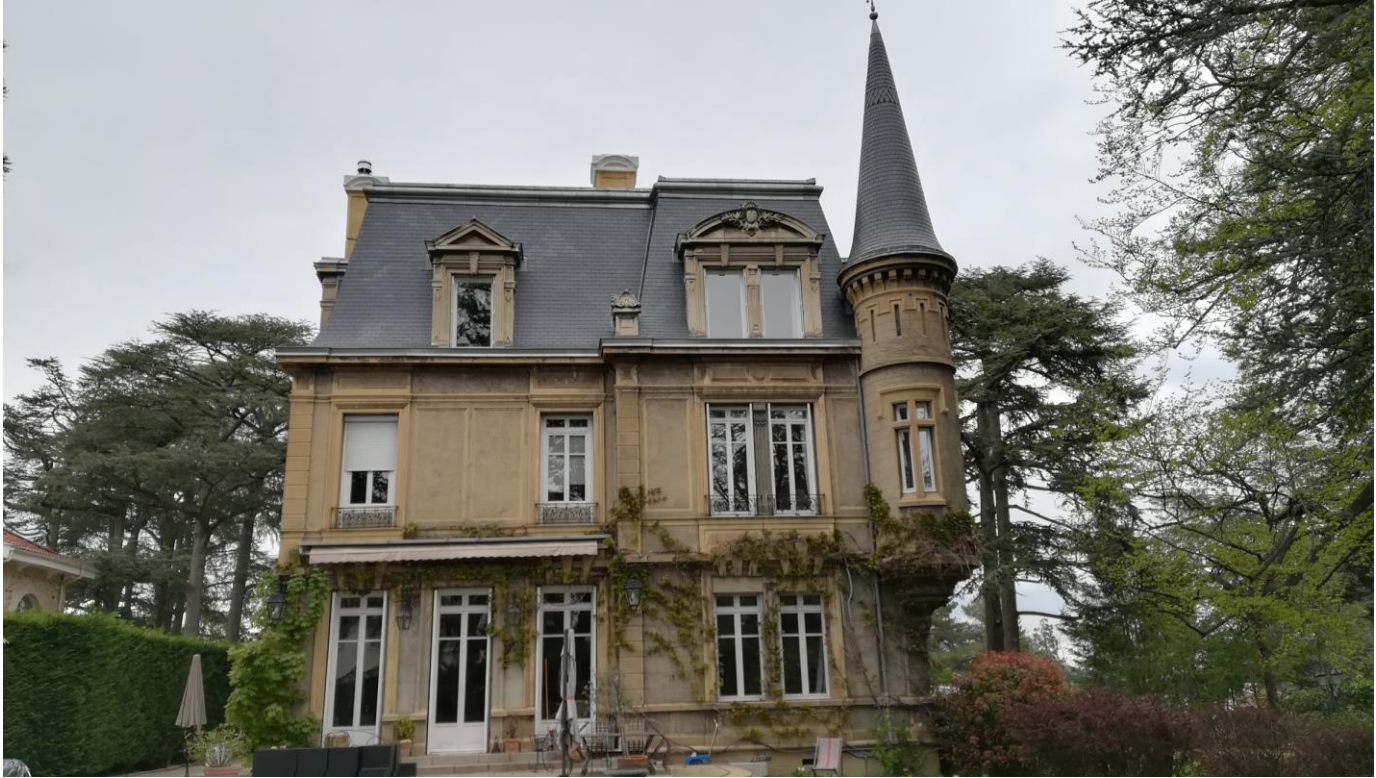
Vue de la façade latérale ouest. Jeux d'ornements composés de lucarnes, cheminées et échauguette
