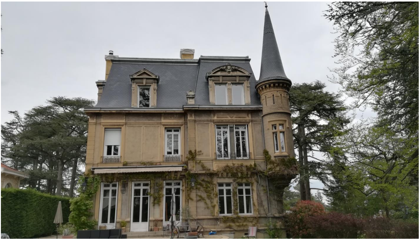
Vue de la façade latérale ouest.
