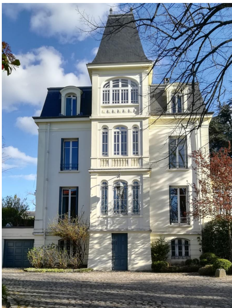
Façade nord sur rue
