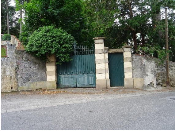
Ancienne entrée sur la rue Michel Laval
