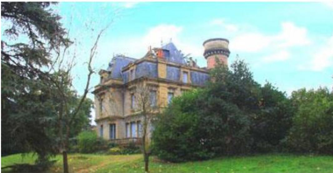
La construction est développée sur 5 niveaux, avec un niveau mansardé de grandes dimensions. Elle est réalisée en béton moulé et briques.
