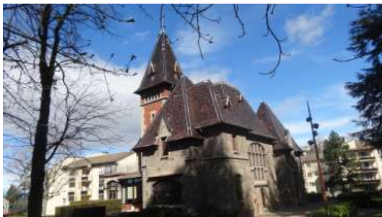
Vue arrière de la maison
