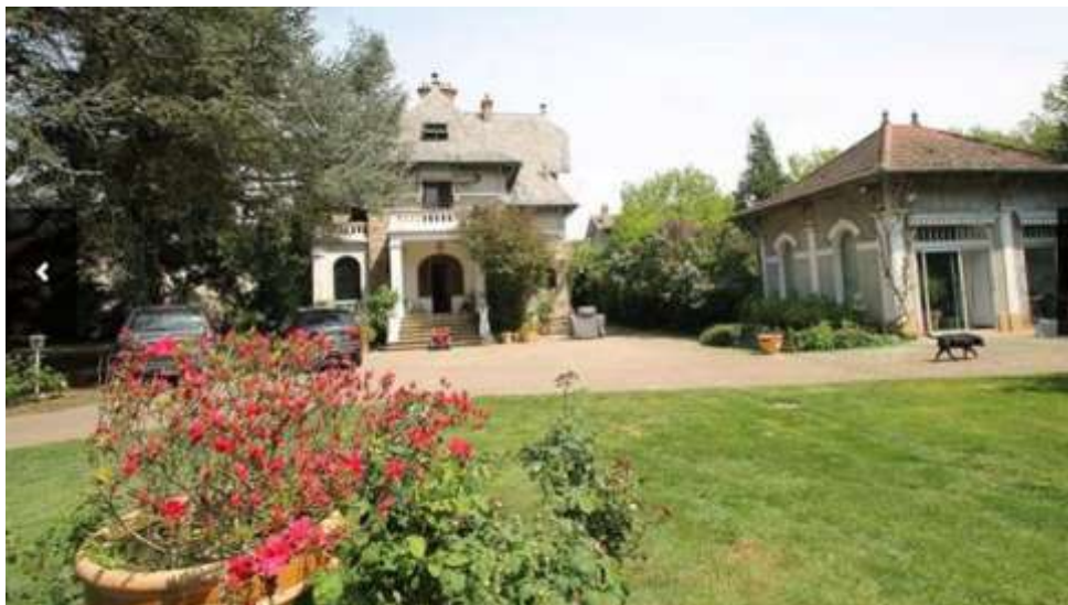
Façade ouest avec petit bâtiment annexe
