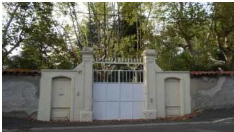
Portail d'entrée sur le rue de la Chaux
