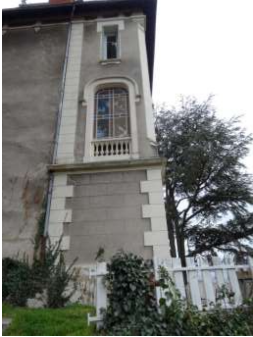
Détail des faces latérales de l'avant corps
