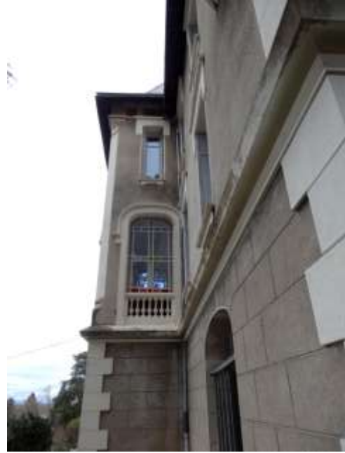
Belles fenêtres avec moulures, vitraux et balustres. Chaînages d'angles blancs sur fond de pierres en granit
