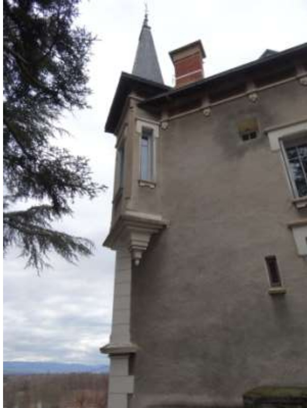
Tourelle d'angle et oriel à fenêtres très étroites
