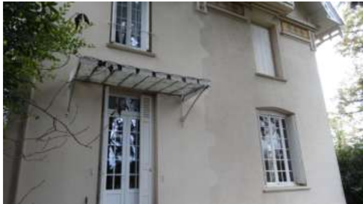
Pièce ajoutée après coup (salle de billard) à l'arrière de la maison, couverte d'une terrasse
