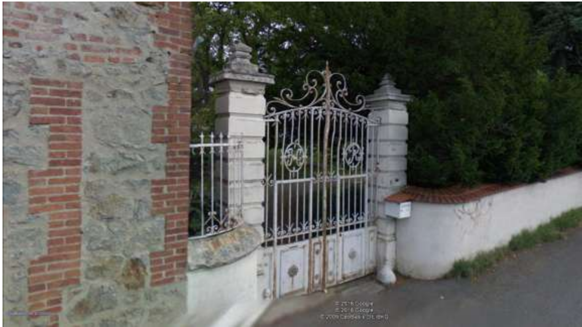
Le portail d'entrée entre les deux piles, avec le monogramme H et R pour Henri Rebeaud constructeur de la maison. La maison du jardinier est à gauche.
