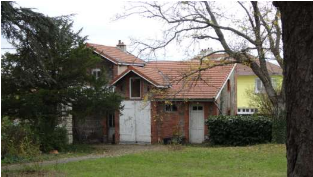
Près du portail d'entrée se trouve un petit bâtiment qui était celui du logement jardinier/concierge et des écuries
