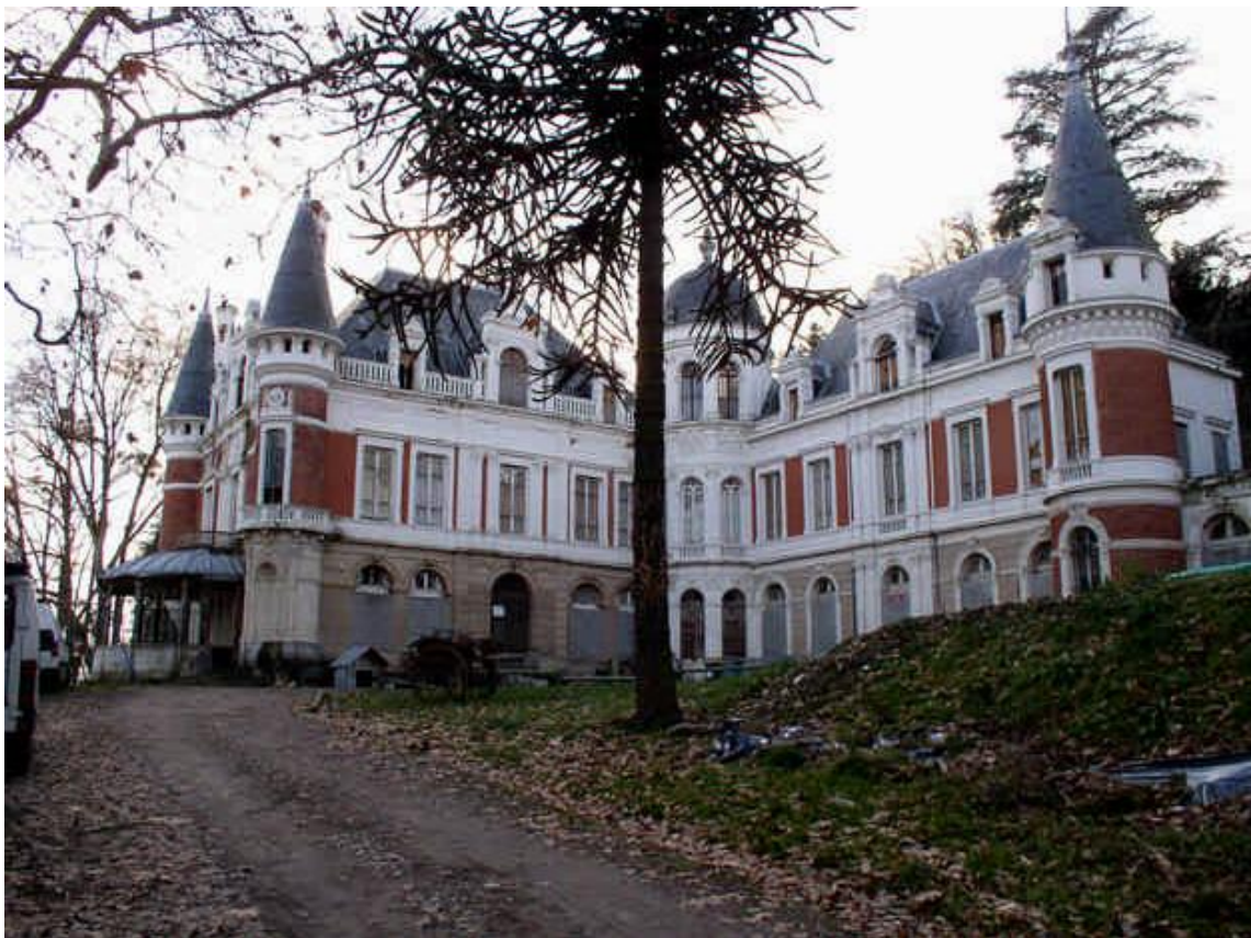
Etat du bâtiment pendant les travaux de rénovation
