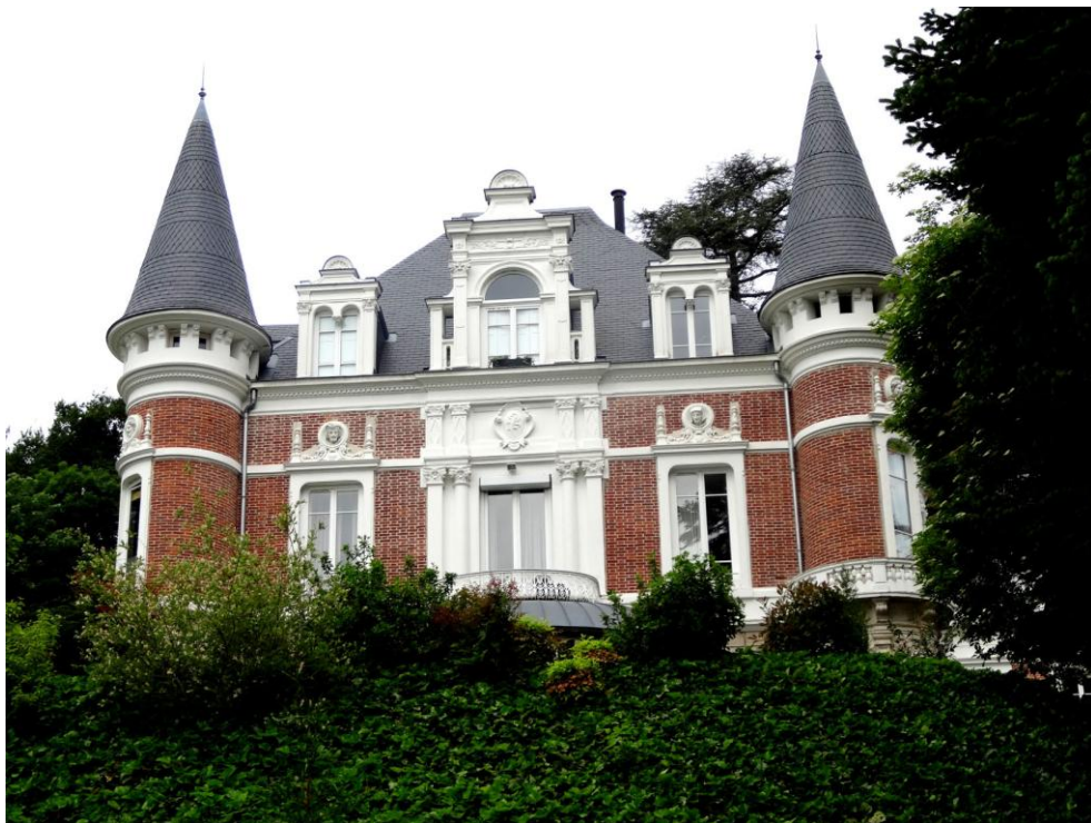
Détail de la façade : corps de logis sur 2 niveaux et mansardé, encadré de tourelles en poivrières. Superbes fenêtres et lucarnes avec encadrements ; médaillons ornés de têtes sculptées
