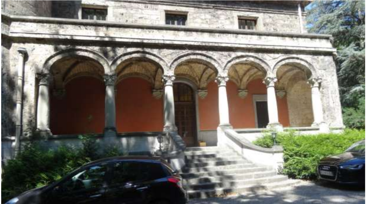
Une superbe loggia ou péristyle desservie par un escalier orne la façade est
