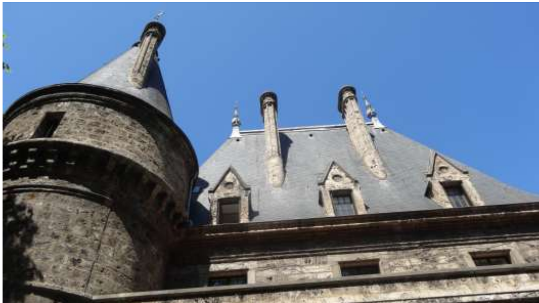
La toiture présente des découpes complexes : les chiens assis, les tours, les épis de faîtage, et surtout les cheminées sont traités comme des éléments décoratifs
