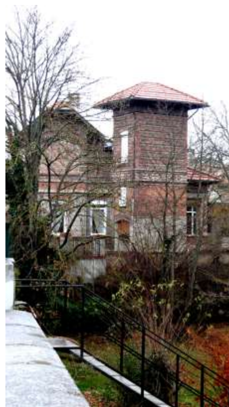
Façade principale sur le côté du parc et du Furan
