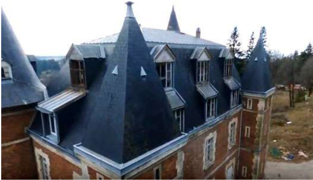
Façade arrière (Photo Drone flight #1)
