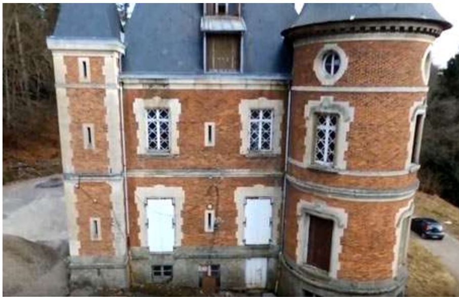
Façade latérale (Photo Drone flight #1)
