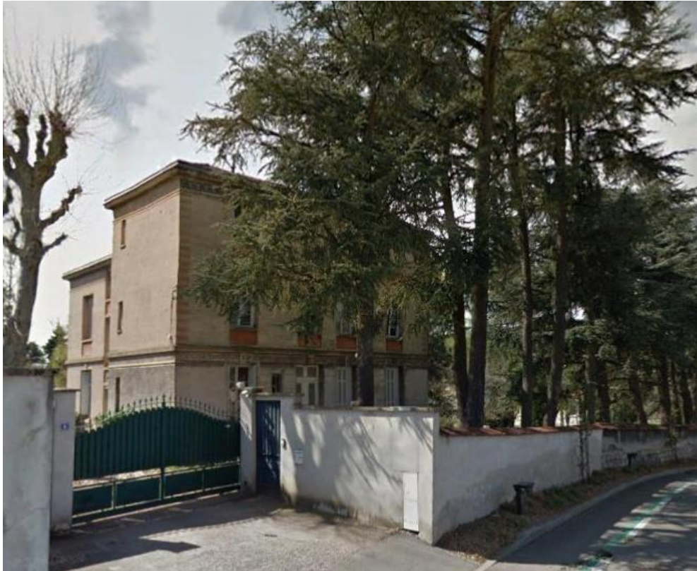
Vue arrière de la maison
