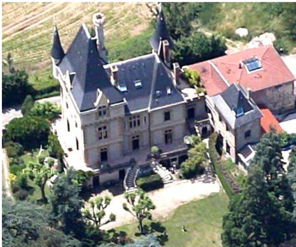
Vue aérienne sur la façade est
