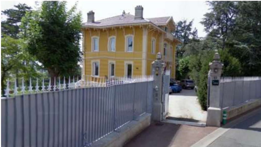
Façade sur la rue
