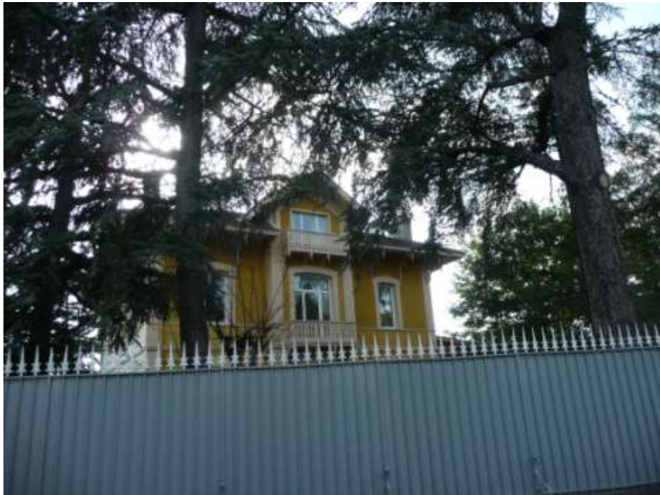
Façade sur la rue
