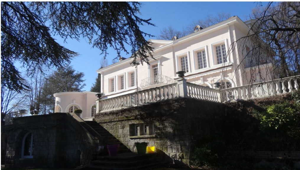
La façade principale sud sur la terrasse
