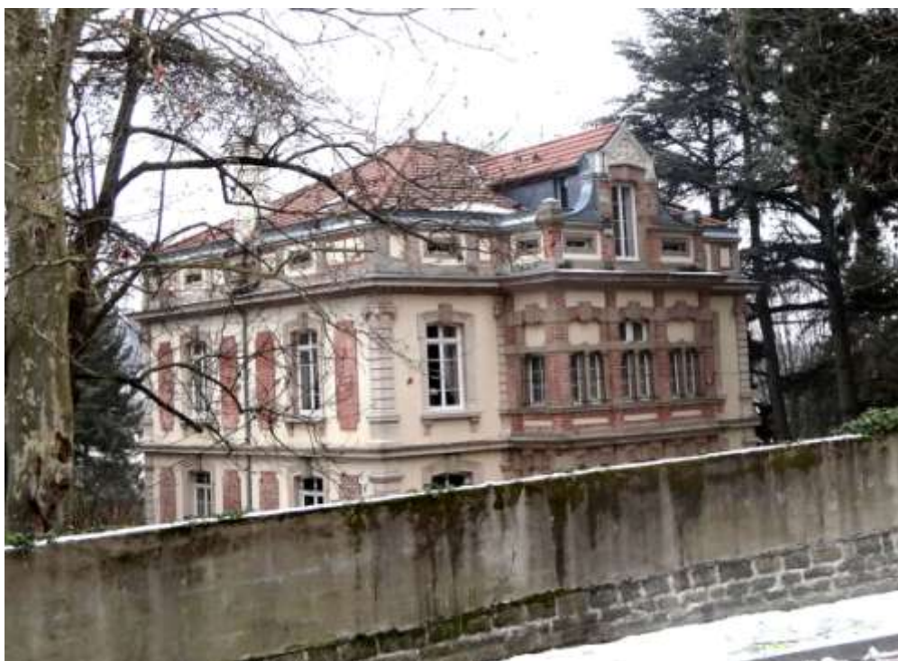
Façades ouest et nord
