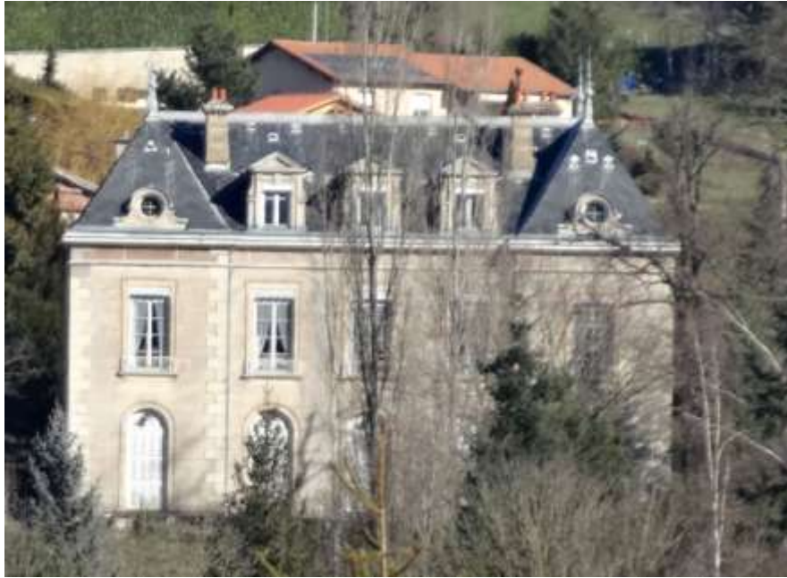
Trois lucarnes à fronton sont insérées dans la toiture et deux oeils de bœuf dans celle des deux ailes de part et d'autre du corps central.
