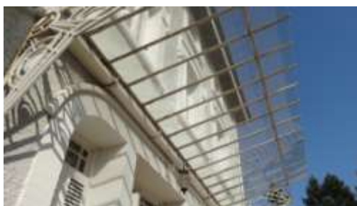
Verrière sur la terrasse
