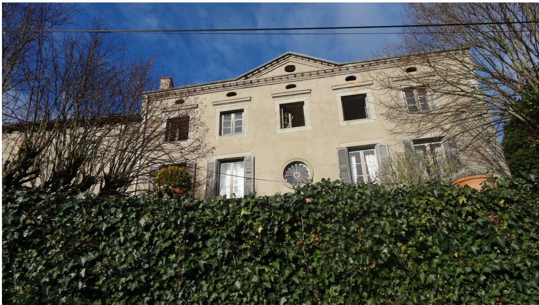
La façade principale
