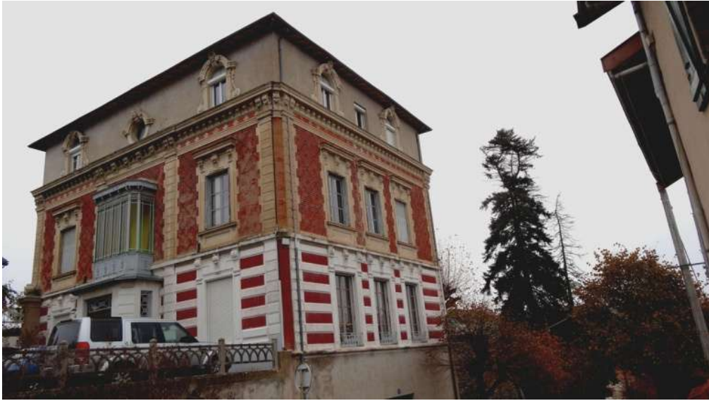
Façades nord et est
