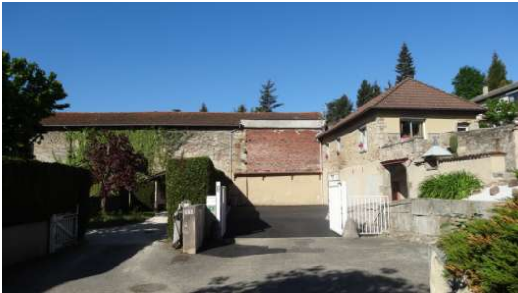
Bâtiments de ferme restaurés
