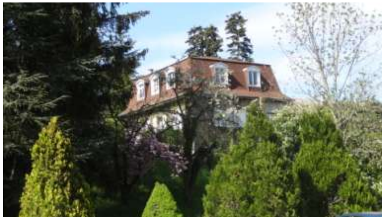
Bâtiment ancien rehaussé d'un étage
