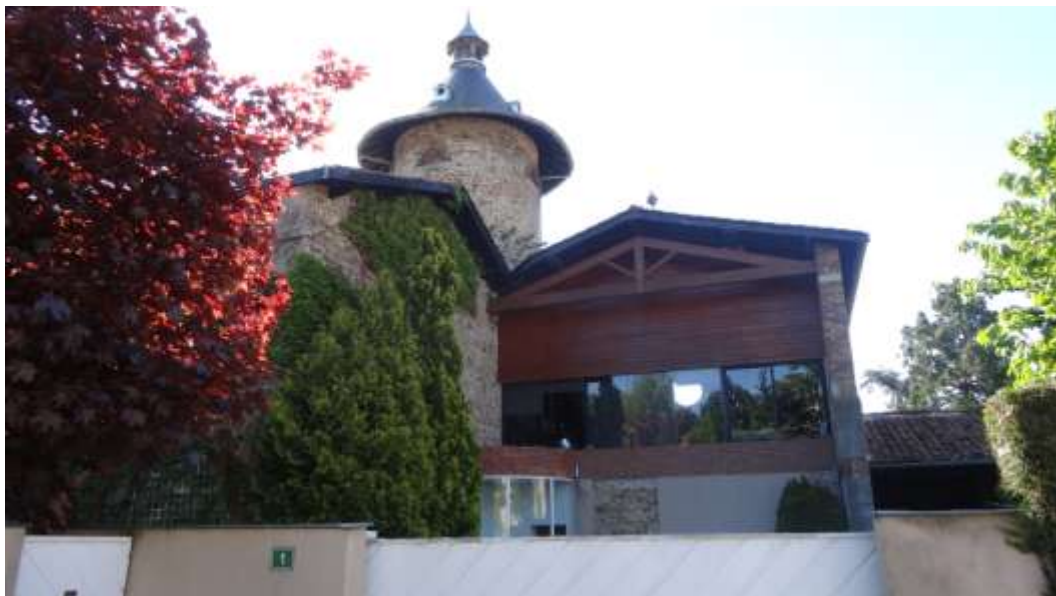
Bâtiment avec pigeonier restauré
