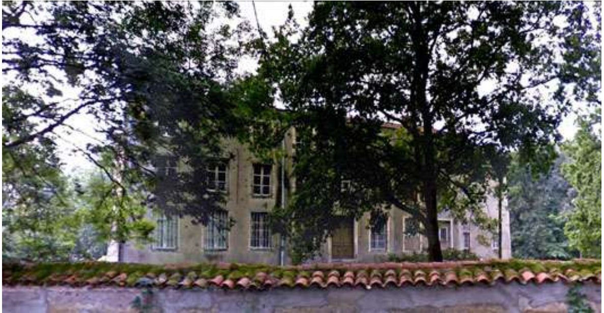
Façade principale. Les deux pavillons qui encadraient le bâtiment ont disparu.
