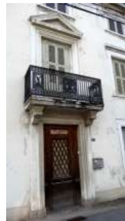
porte d'entrée et balcon
