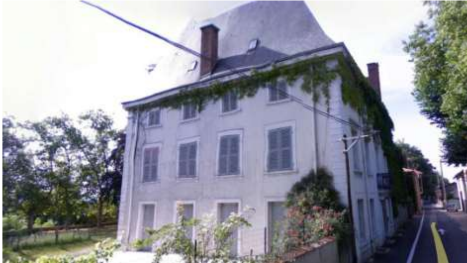
La façade sud après démolition du pavillon
