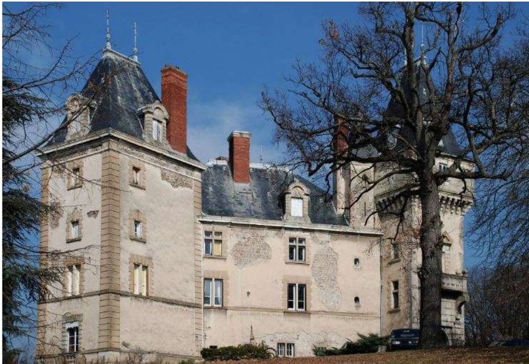
Façade arrière donnant sur le parc
