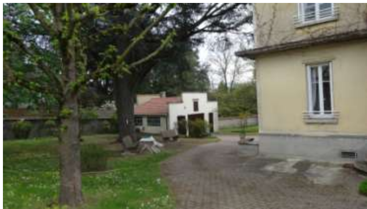
Bâtiment annexe comportant la buanderie
